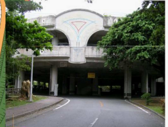
⑭ 運動公園立体駐車場入口
