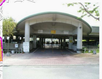
⑫ 運動公園立体駐車場入口
