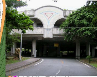
⑭運動公園立体駐車場入口
