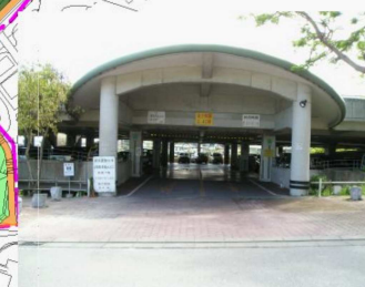
⑫ 運動公園立体駐車場入口
